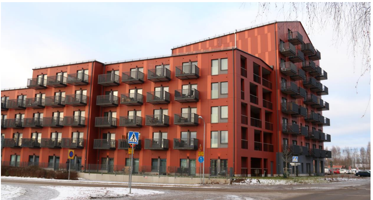
Nybyggnation på Norra Järnvägsgatan (Amasten) Foto: Lars Gustafsson
