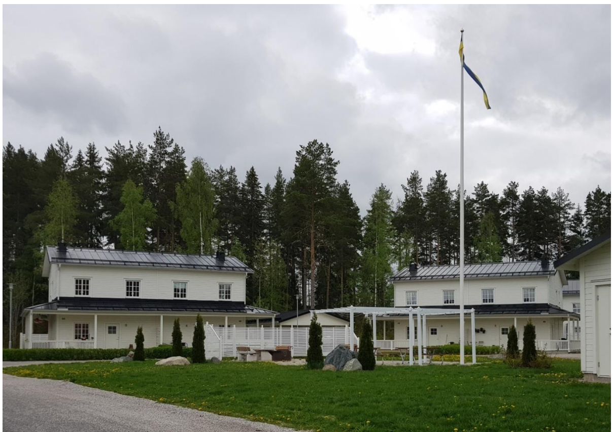
Hultqvist fastigheters byggnation Sandsberg i Sundborn. Foto: Christer Johansson
